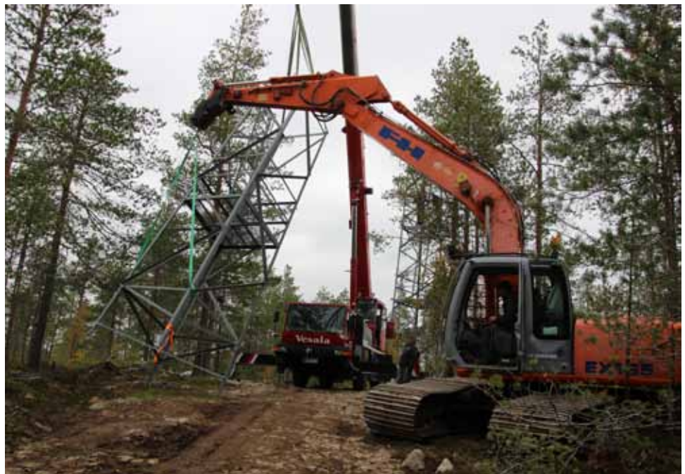
Kuuden metrin korkeuteen ulotuttiin kaivinkoneella.
