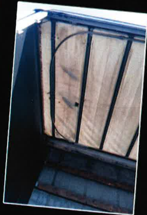
19.8.2019 oli vuorossa sisäverhouksen kiskojen asennus
