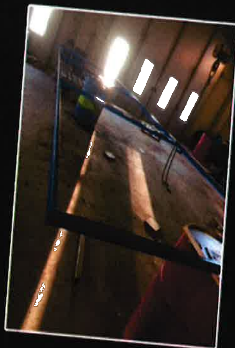
Lisäkatoksen runko hitsattiin ja maalattiin. Rungon päälle asennettiin sinistä vedenkestävää pressua
